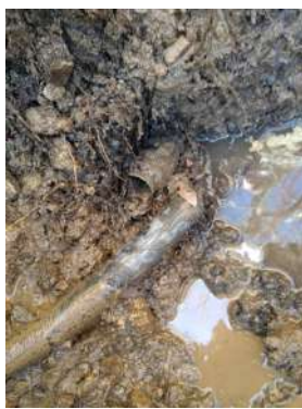
Fuite d'eau réparée à Peyre
