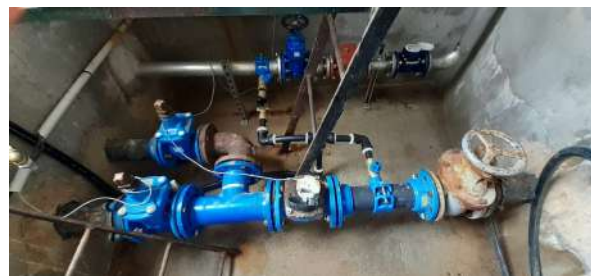
Renouvellement de la canalisation d'alimentation : changement tuyauterie qui était bien rouillée et installation d'un by-pass entre l'alimentation et la distribution.
