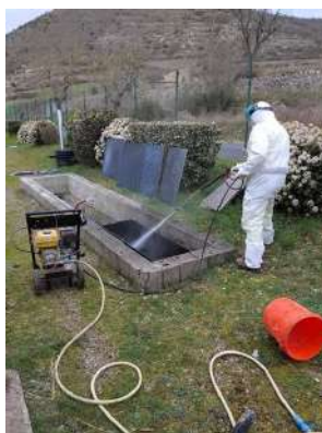
Entretien des stations d'épuration de niveau 1.
